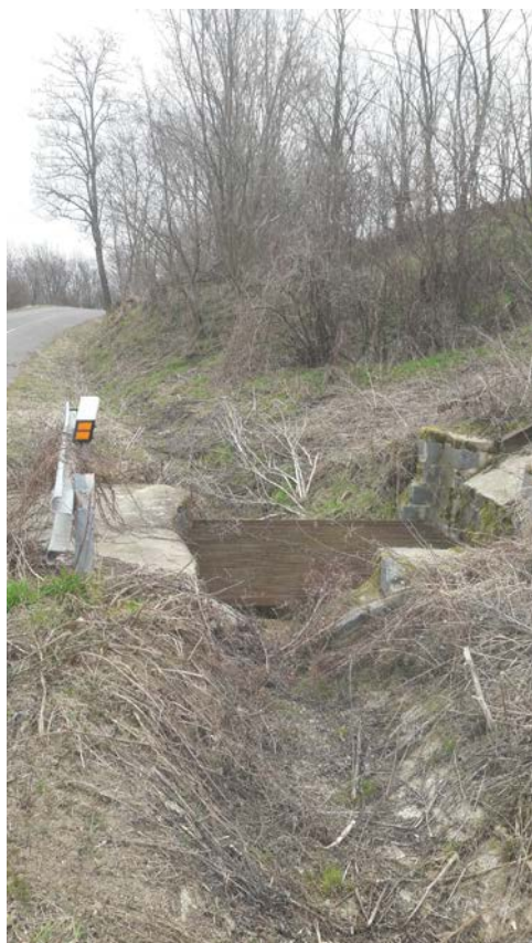
Obr. č.1 Vývařiště nad propustkem č.2
