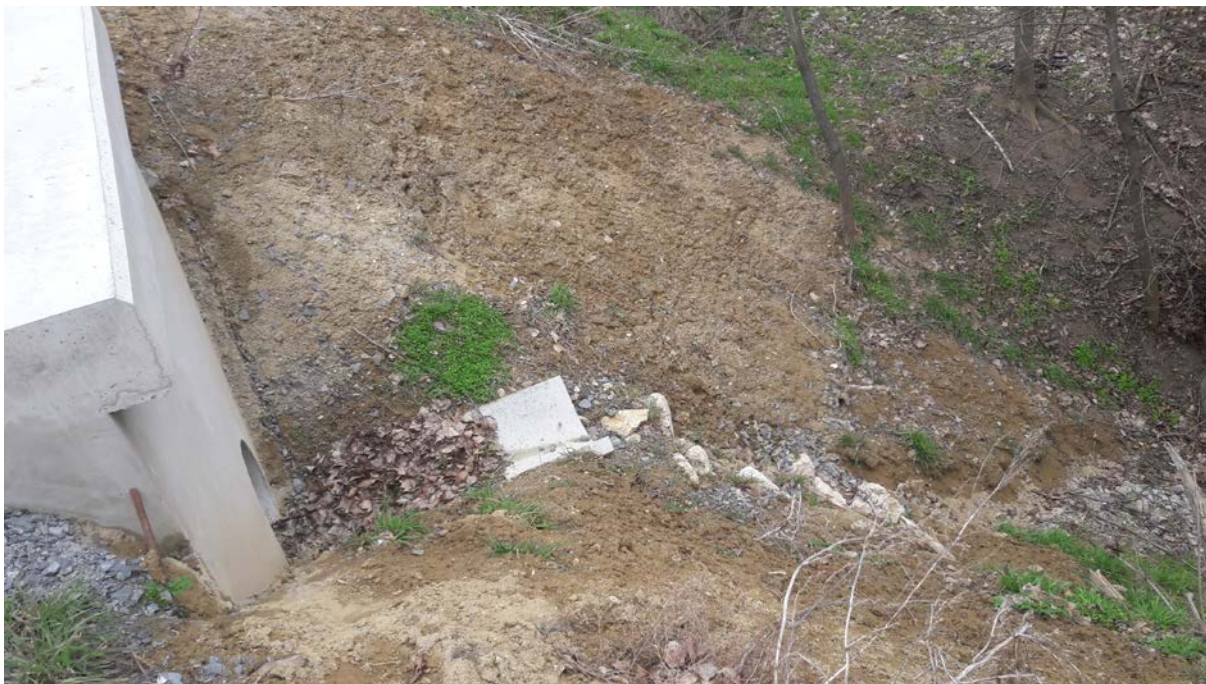
Obr. č.4 výtokové čelo propustku č.3 – svah pod bet. korytem bude opevněn
