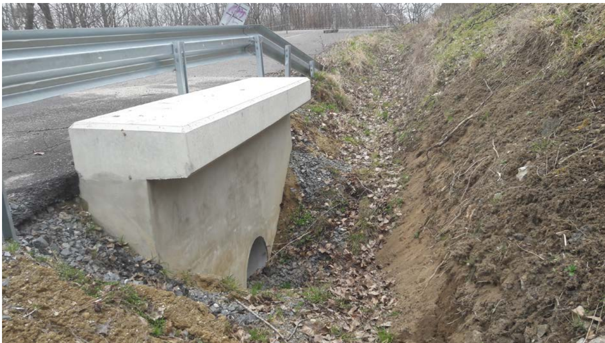
Obr. č.3 nátokové čelo propustku č.3 – zde bude osazena horská vpuť
